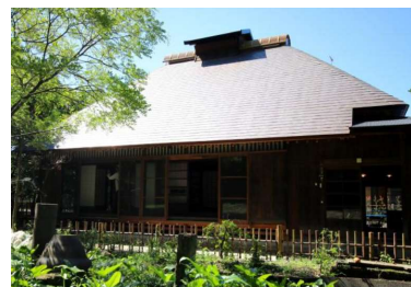
三鷹市大沢の里古民家
