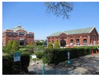
GAS MUSEUM (ガスミュージアム)
